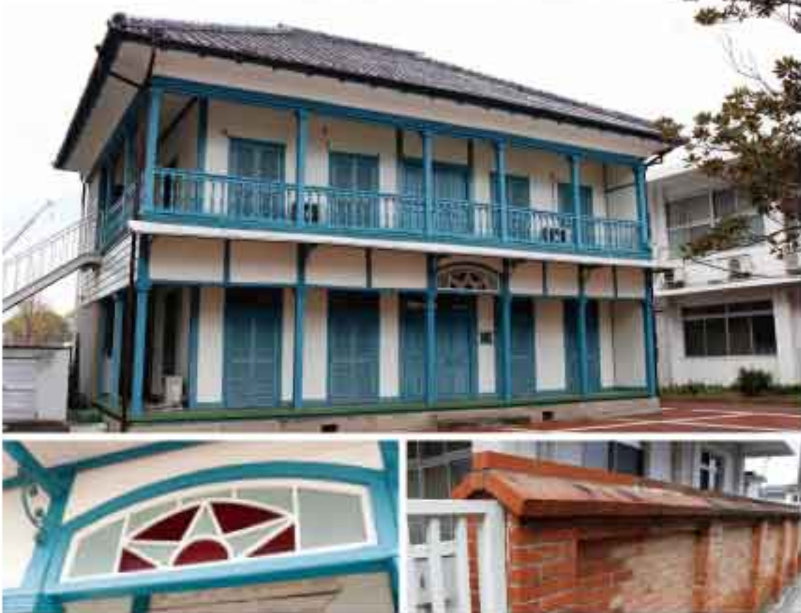
1階中央扉の手に施されているステンドグラス「ファンライト」 八代では珍しい機瓦葺。大正8(1919)年建設。小屋根が特徴的。
