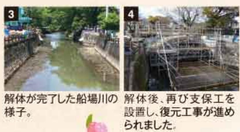
解体が完了した船場川の解体後、再び支保工を設置し、復元工事が進められました。
